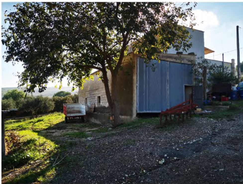
Lato ingresso magazzino
