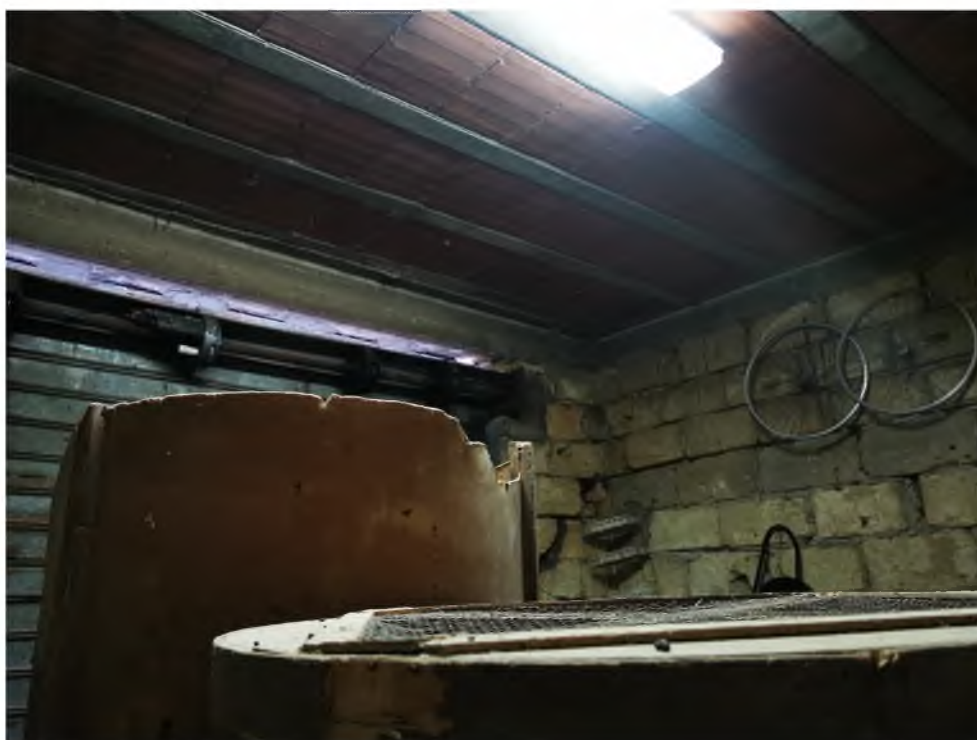
Interno magazzino (parte da demolire)
